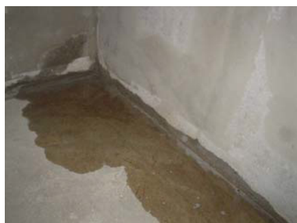
切付からの漏水に効果的です
